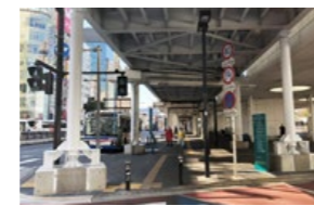
耐震補強工事(京急川崎駅～八丁駅)
