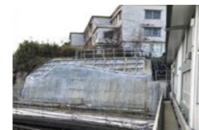
法面防護工事(追浜駅構内上り線側)
