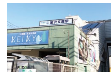
駅施設での太陽光発電設備の設置
